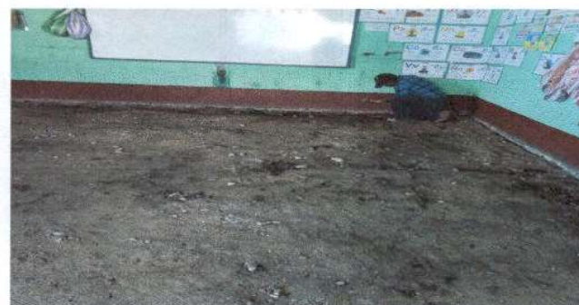
Foto 4: Sustrución de Piso de Granito.
