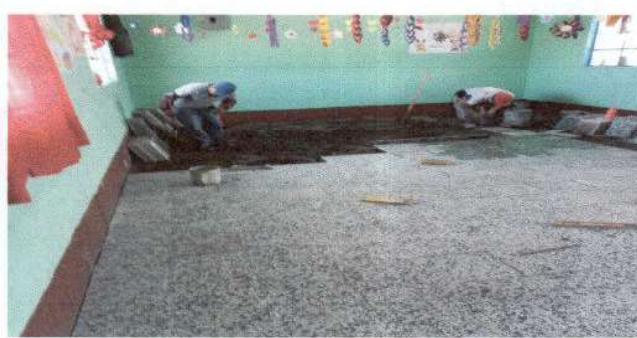
Foto 2: Sustrución de Piso de Granito.
