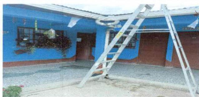
Foto 5: Reparación de bajada de agua.
