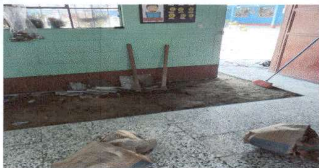
Foto 3: Sustrución de Piso de Granito.
