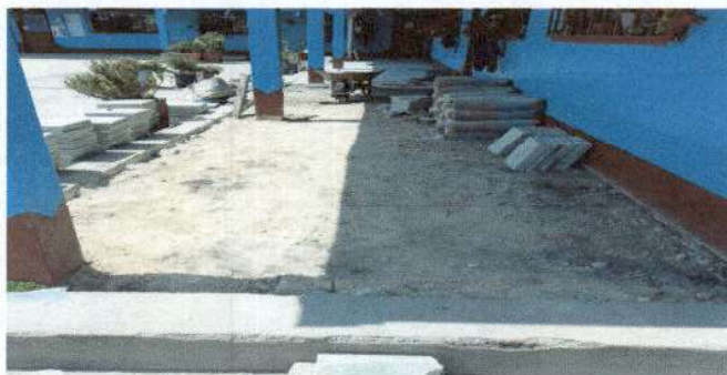
Foto1: Sustrución de Piso de Granito.
