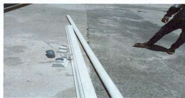
Foto 6: Reparación de bajada de agua.
